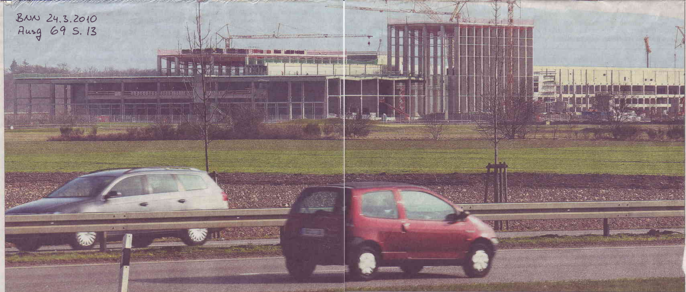
WIE EINE GRAUE WAND wird aus der Perspektive der Karlsruher Rheinstrandsiedlung – im Bild ist vorn der Verkehr auf der B 36 zu sehen – die Fleischfabrik von Edeka auf Rheinstettener Gemarkung vor die Kulisse der Schwarzwaldhöhen gepflanzt. 15 Meter hoch sind die Hallen der insgesamt 350 Meter langen Wurstproduktionsstätte. Die Pfeiler des Hochregals ragen an die 30 Meter auf. Foto: jodo
